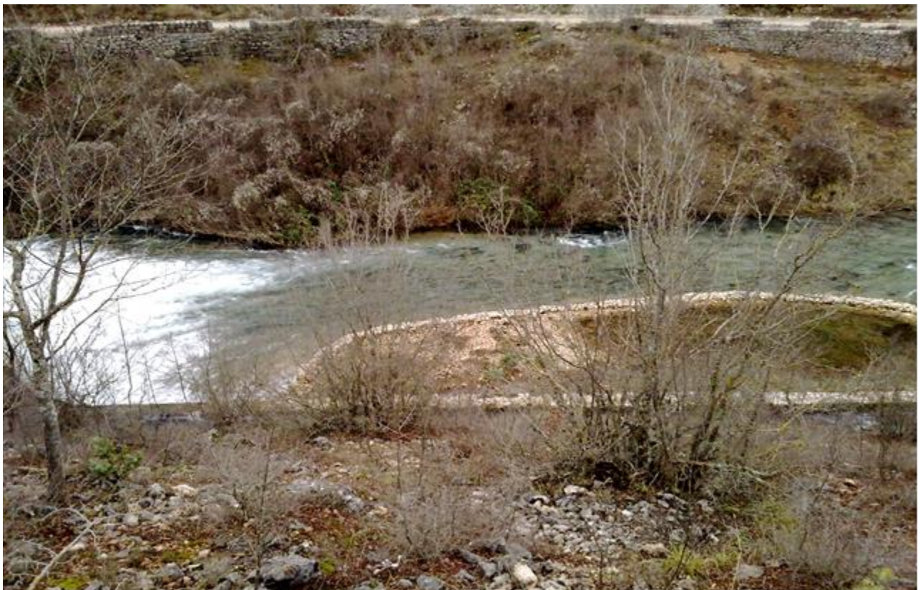
Slika 7.8 Dovodni kanal za mlinicu
