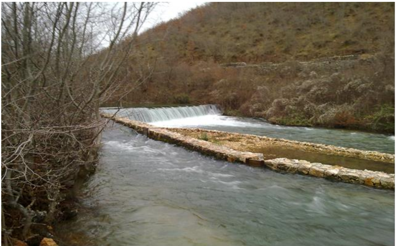
Slika 7.6 Postojeći prag i dovodni kanal
