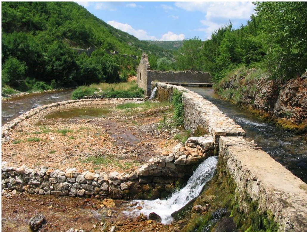
Slika 2.10 Pogled na postojeći dovodni kanal koji se rekonstruira
