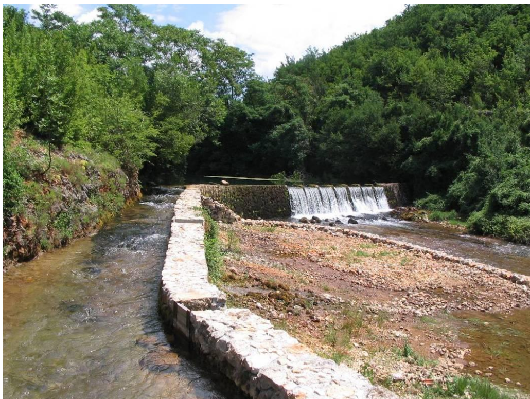
Slika 2.11 Pogled na dovodni kanal i uzvodni prag (branu)
