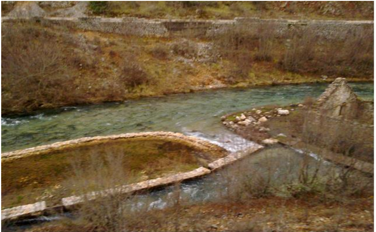
Slika 7.7 Dovodni kanal za mlinicu
