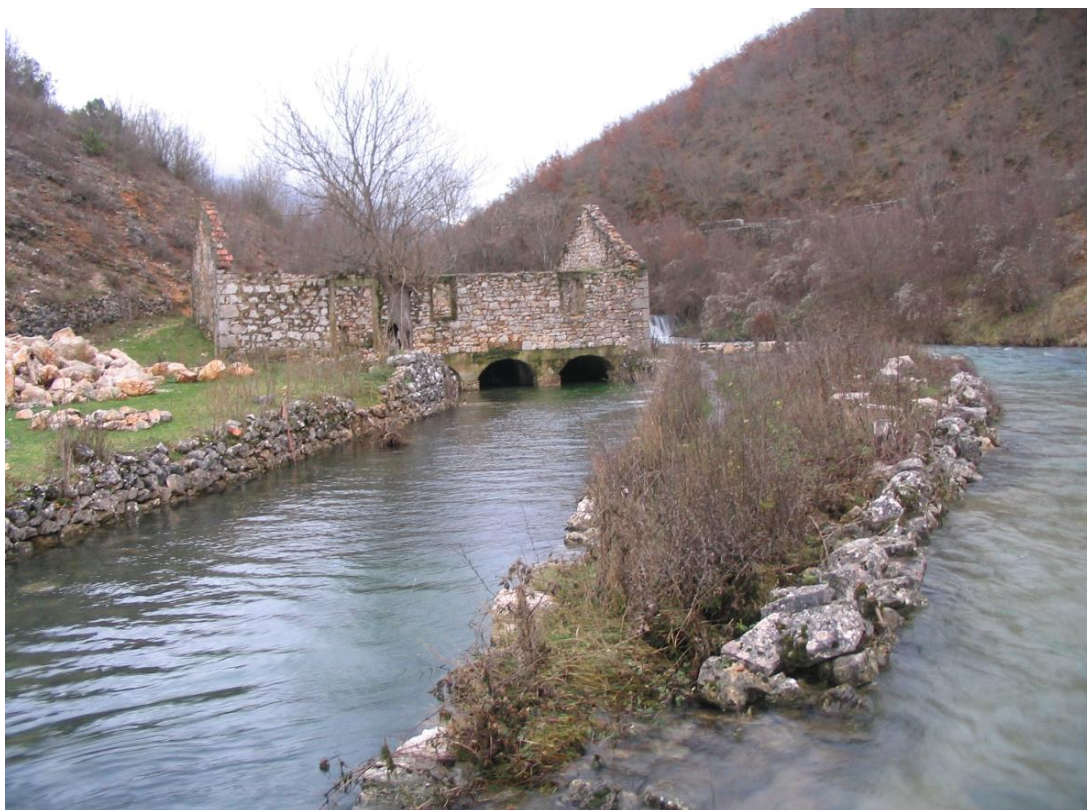
Slika 2.13 Pogled na postojeći odvodni kanal koji se rekonstruira
