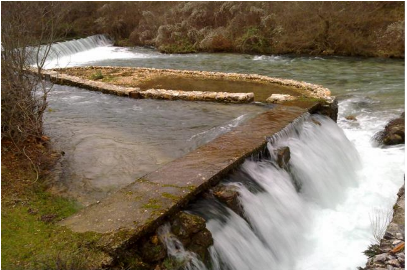
Slika 7.5 Postojeći prag i dovodni kanal
