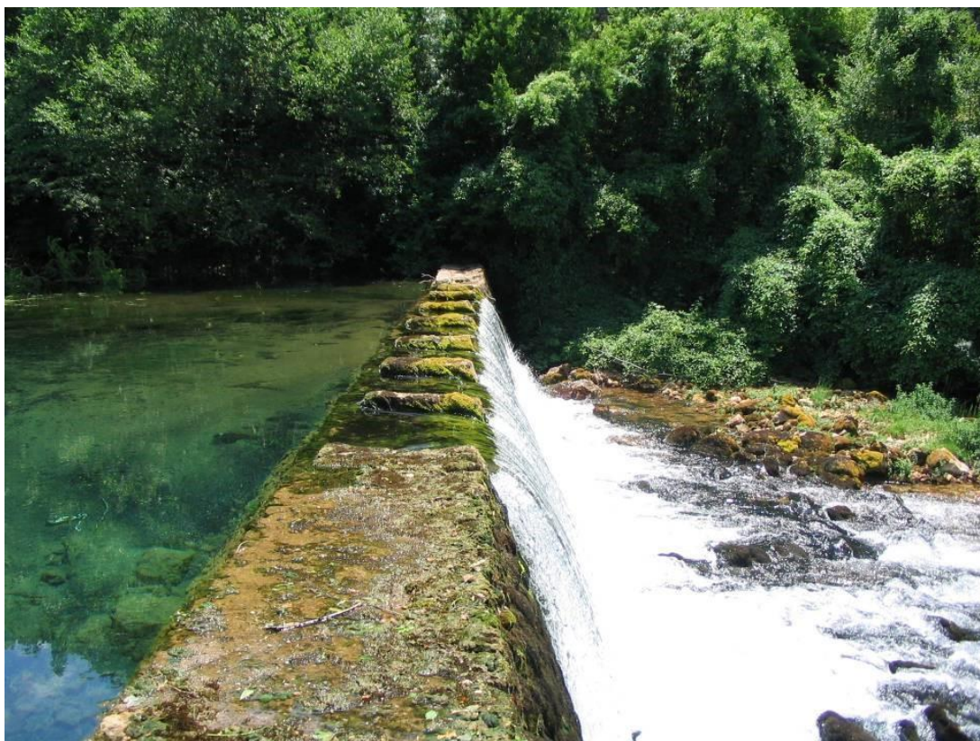
Slika 2.8 Pogled na postojeći uzvodni prag koji se rekonstruira
