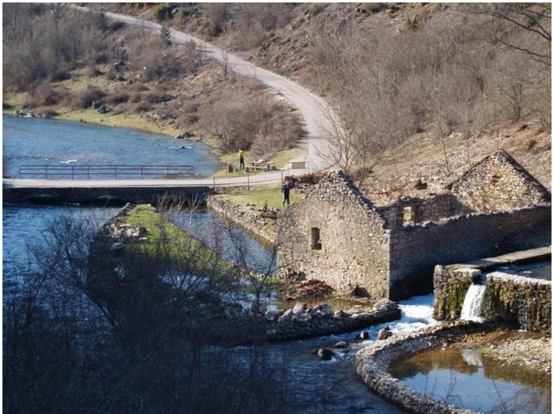
Slika 2.7 Pogled na Đurićevu mlinicu koja se rekonstruira
