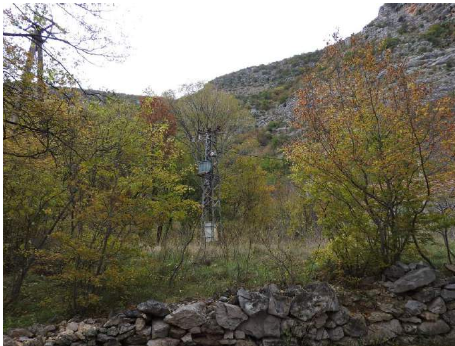
Fotografija 2-3: Postojeća trafostanica
