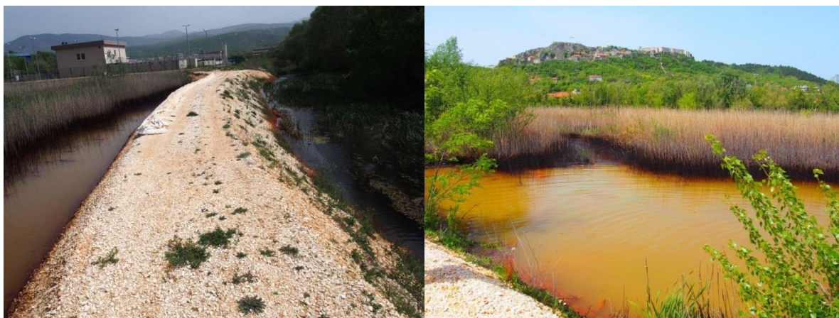
Slike 14. i 15. Na slici lijevo vidljivi su ostaci tzv. zečjih nasipa kojima se branila istjecanje zagađene vode iz lagune u rijeku Orašnicu (desno od nasipa). Na slici desno pogled od lagune na Kninsku tvrđavu. Crno što se vidi na trstici je sloj ugljikovodika.
