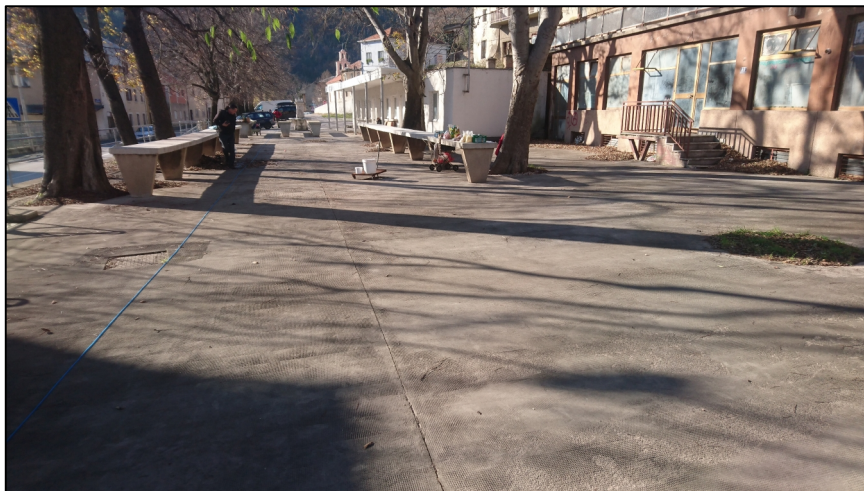
Slika 2. Pogled na Staru tržnicu u Kninu iz istočne strane (slika 3: Kv 1) gdje su u podlozi ploče od armiranog betona. Iz nekog je razloga na tom dijelu istražene površine na dubini ispod 0,5 m jako povišenom vlažnost.
