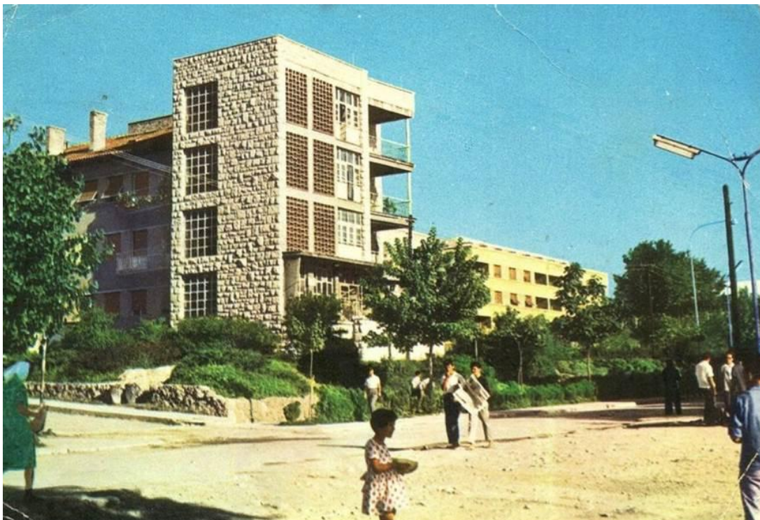
Sl. 75. Zgrada Željezničarskog konačišta, 1969-.1970. (Privatni album)
