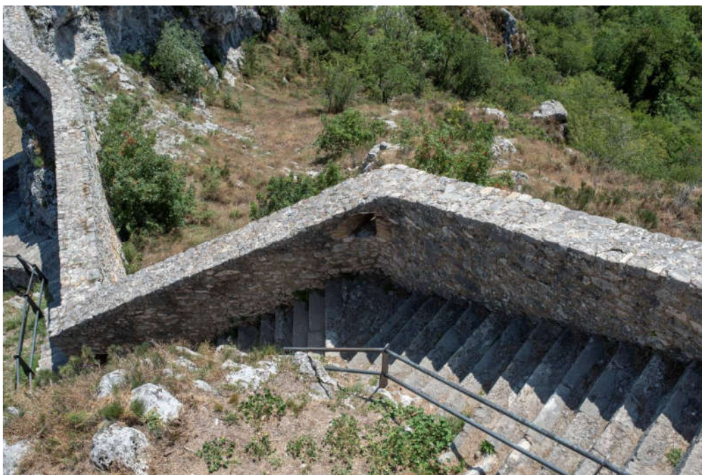
79 – Donji grad, dio zapadnog obrambenog zida od postaje Emo prema kaštelu Lab
