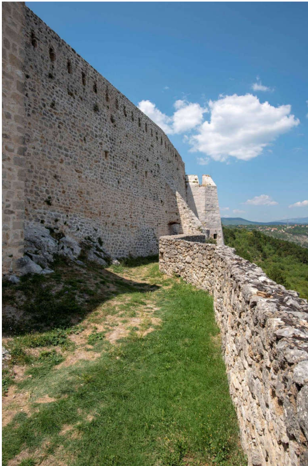
9 – Gornji grad, prilaz mlatačkoj fortifikaciji uz istočni zid
