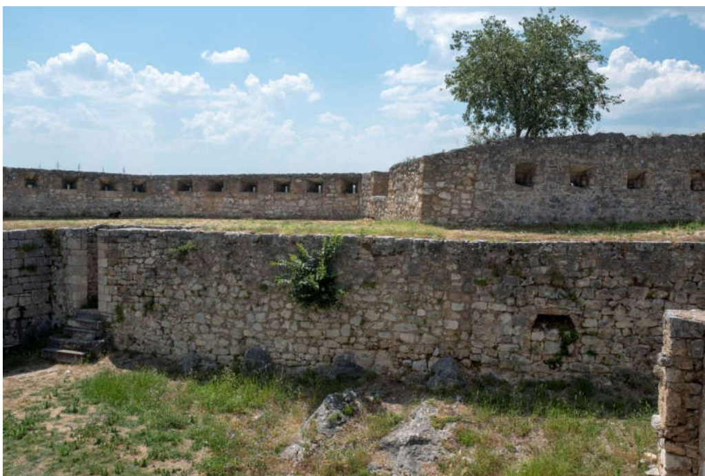
26 – Gornji grad, dio zapadnog obrambenog zida u južnom dijelu dvorišta
