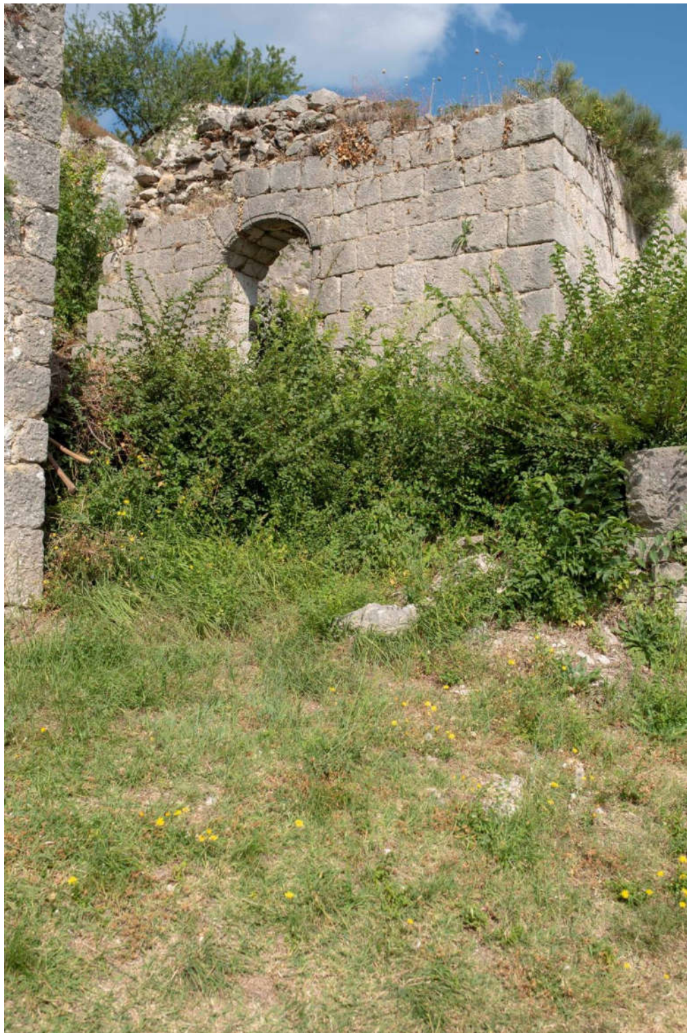
50 – Srednji grad, ulaz na južnom pročelju urušenog skladišta baruta
