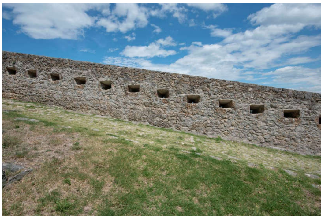
67 – Donji grad, potez istočnog obrambenog zida s nišama puškarnica
