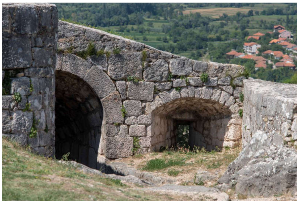
35 – kaštel Lab, pogled sa zaravni na sjeverni ulaz
