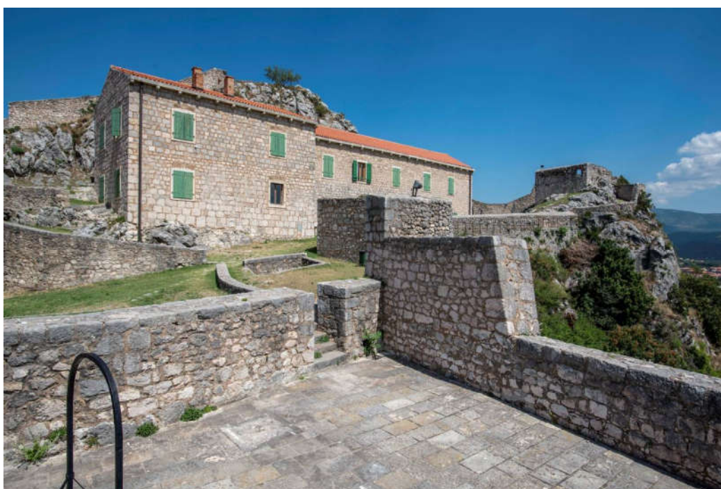
90 – postaja Belveder, pogled s bastiona-cisterne na zgrade bivše vojarne
