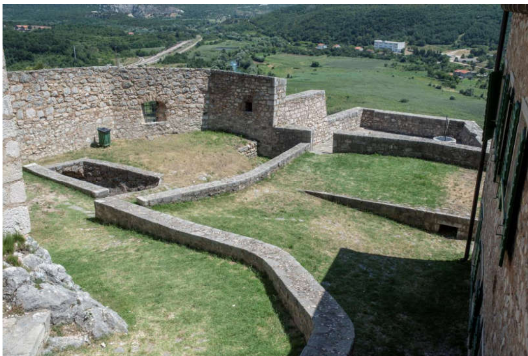
89 – postaja Belveder, pogled sa zapada na bastion s cisternom
