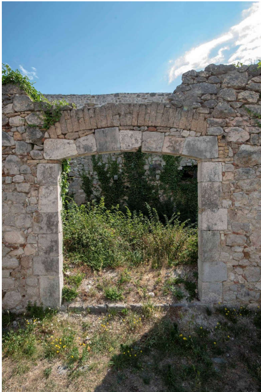
22 – Gornji grad, portal na zapadnom pročelju urušene zgrade vojarne
