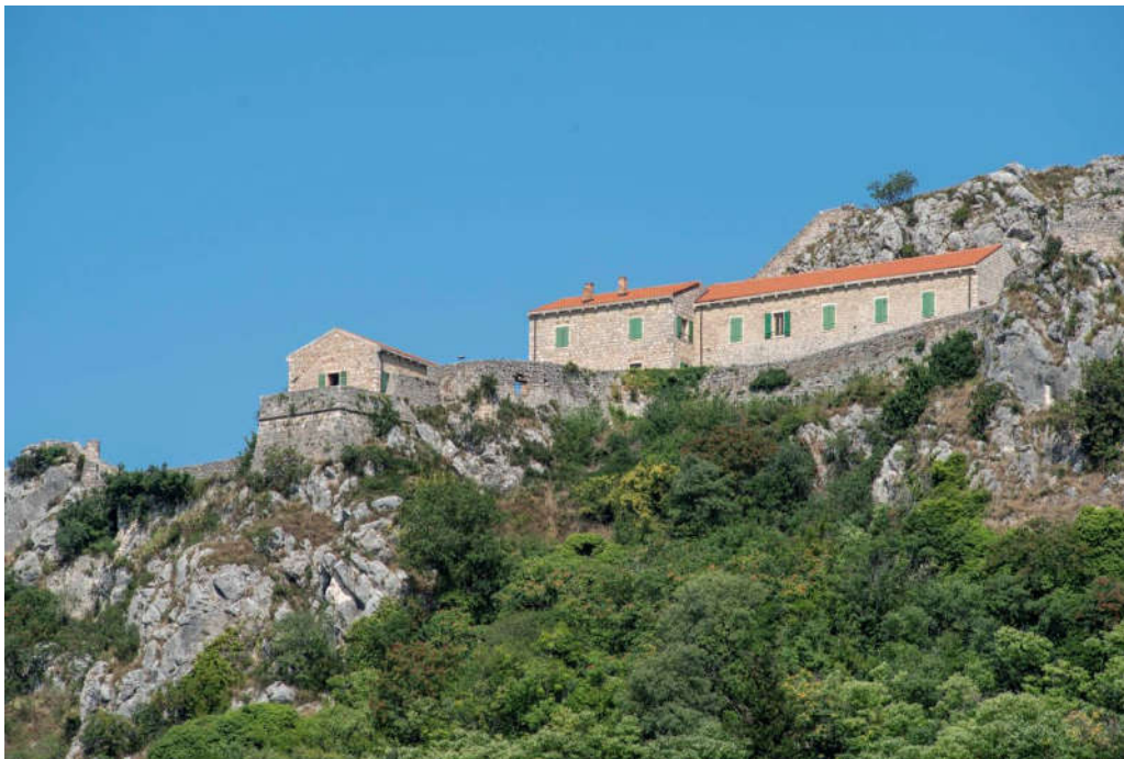
85 – postaja Belveder, potez istočnog obrambenog zida
