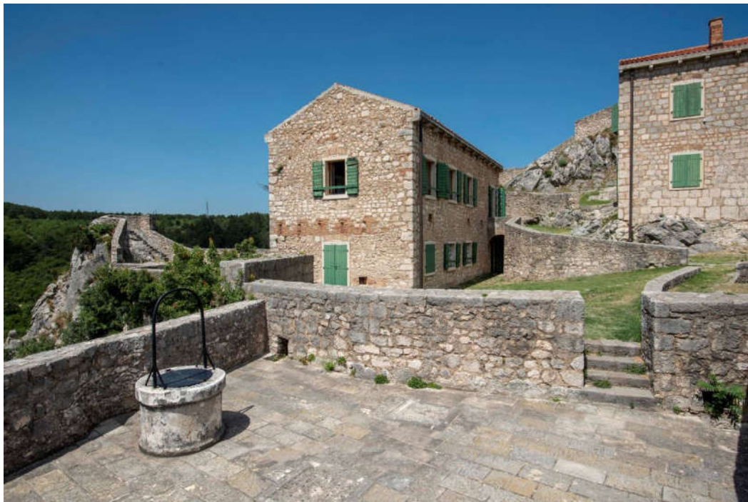
91 – postaja Belveder, pogled s bastiona-cisterne na zgrade bivše bolnice i vojarne
