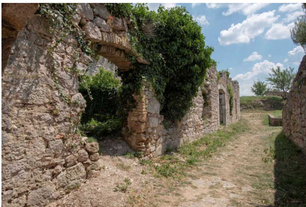
20 – Gornji grad, zapadno pročelje urušene zgrade vojarne
