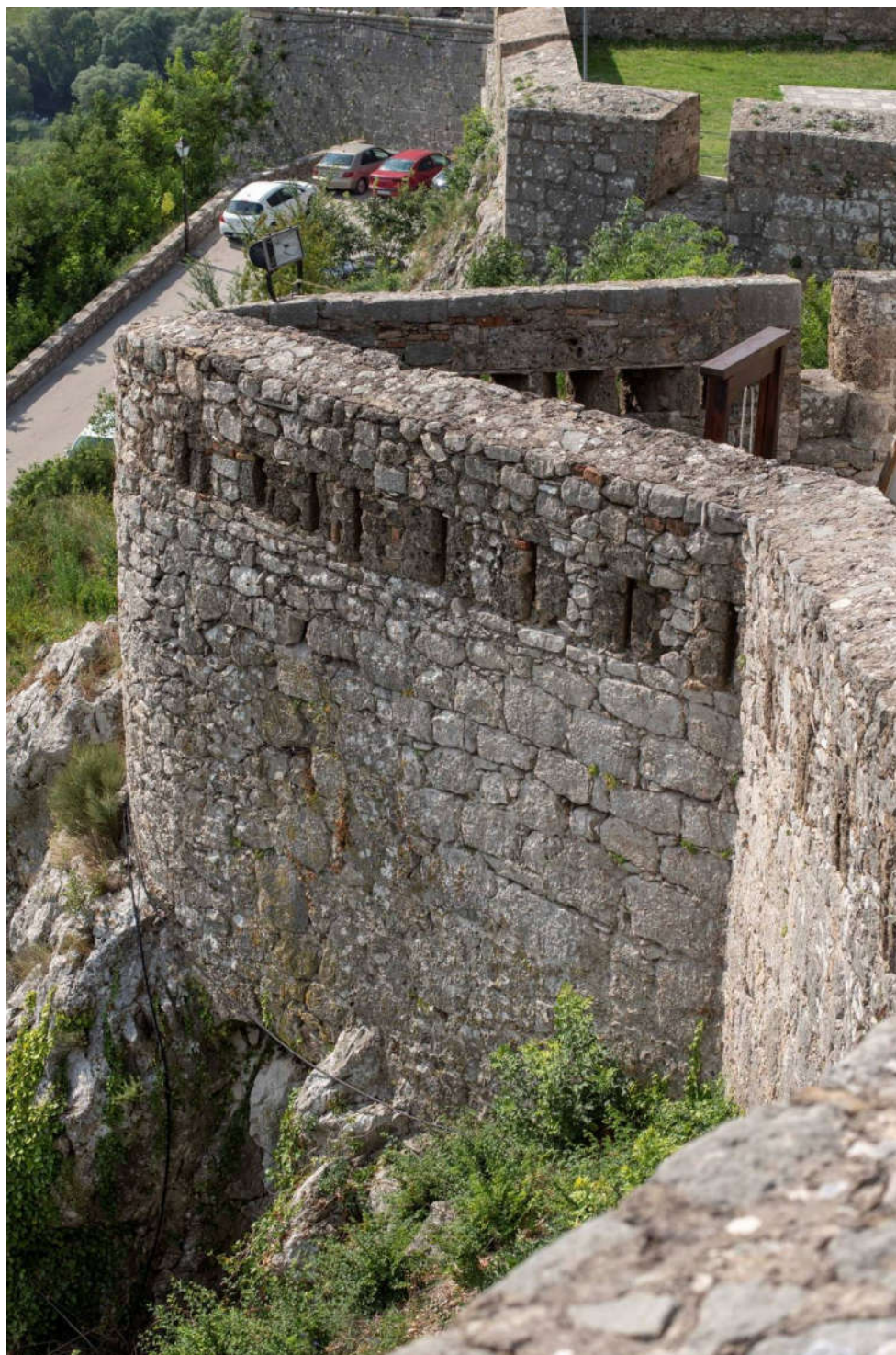
68 – Donji grad, šilj istočnog obrambenog zida pred ulazom u Srednji grad
