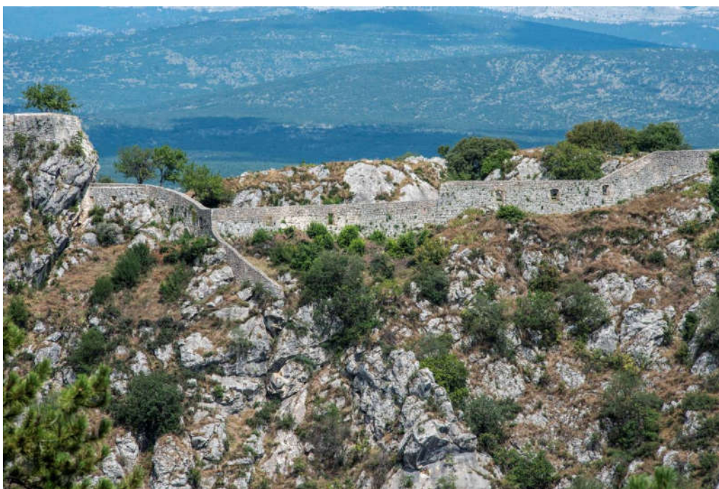
39 – Srednji grad, zapadni obrambeni zid
