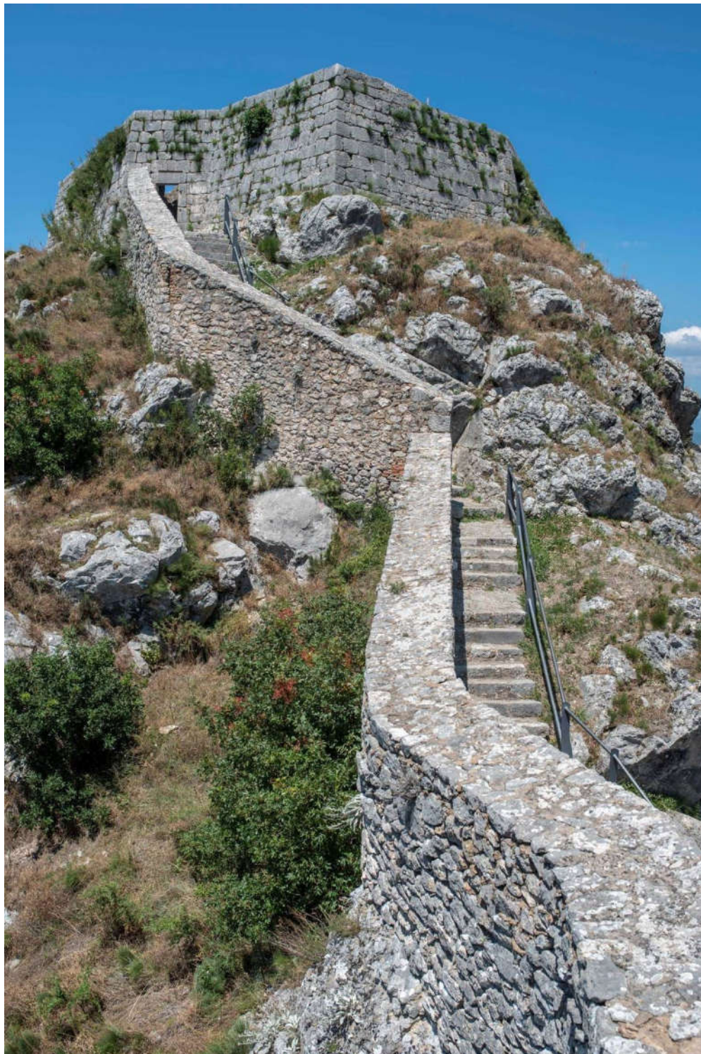
33 – kaštel Lab, pogled s juga
