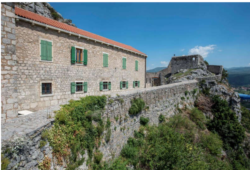
84 – postaja Belveder, pogled s juga na potez istočnog obrambenog zida
