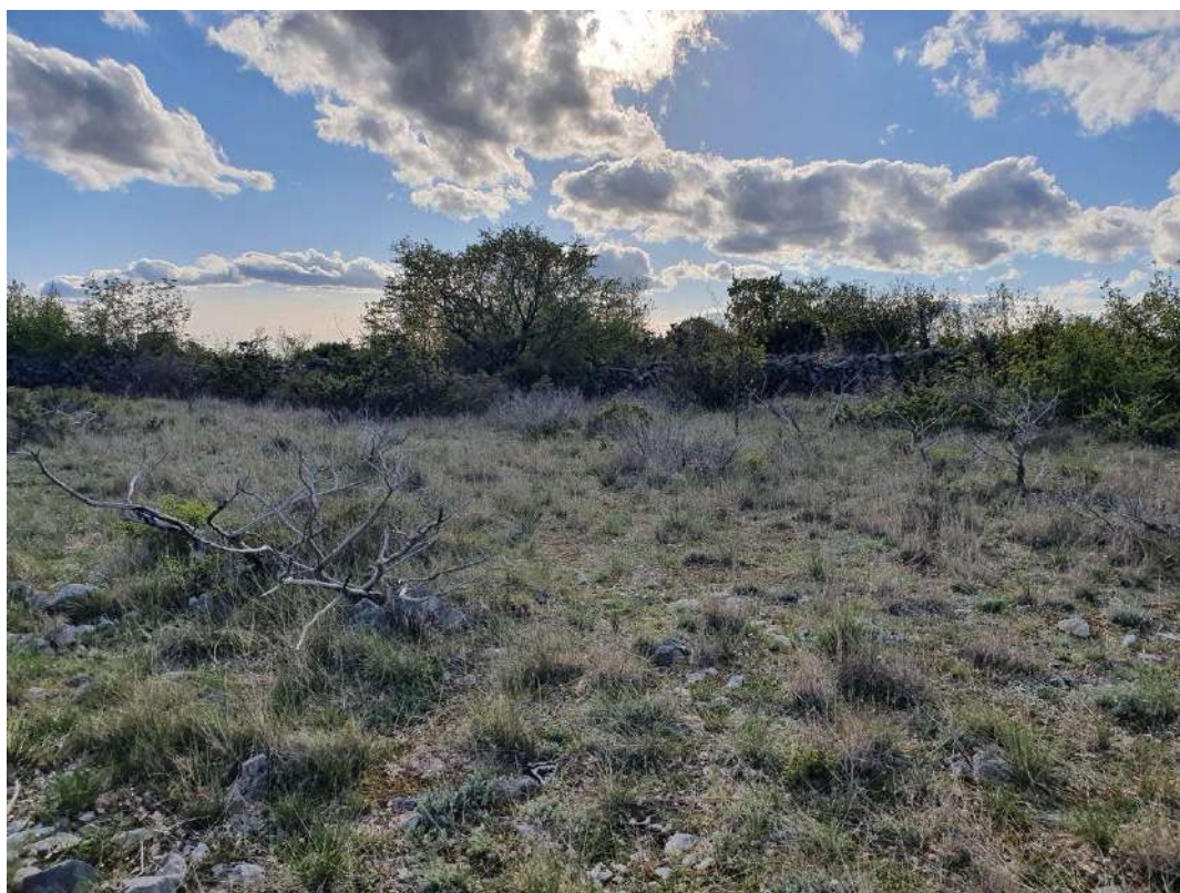
Fotografija C-20: Pogled na suhozid zapadno od prostora trafostanice 110 kV kod Žagrovića
