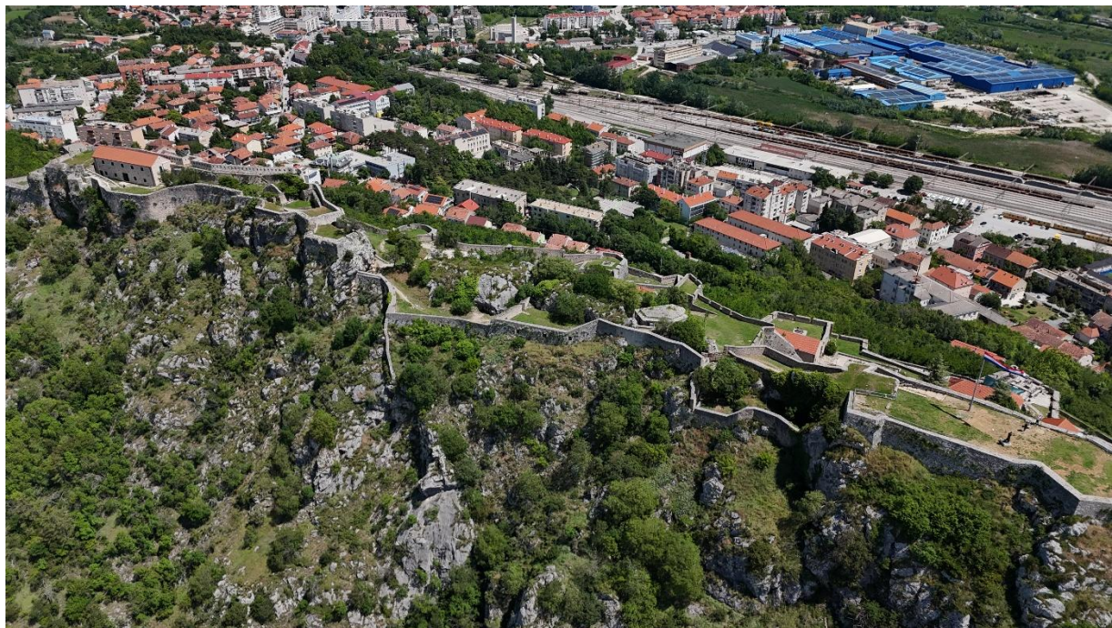
Slika 64. Slike s terena (postojeće stanje) k.č.br. 5811/1, 5811/2, 5812, 5813, 5814, 5815, 5816, 5817, 5818, 5819, 5820, 5821, 5822, k.o. Knin
