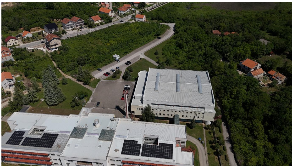
Slika 60. Slike s terena (postojeće stanje) k.č.br. 1820, k.o. Knin
