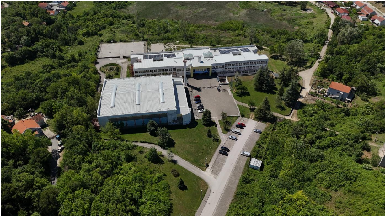
Slika 59. Slike s terena (postojeće stanje) k.č.br. 1820, k.o. Knin
